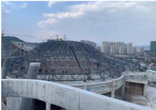
3月10日，随着最后一根钢管杆件成功拼装到位，邵武体育中心项目游泳馆钢网架屋盖顺利收口闭合，标志着集团承建的邵武体育中心项目又完成一个重要节点。
