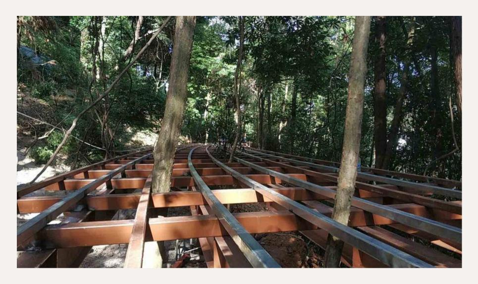
近日,集团承建的麒麟山步道项 目钢构部分正式开始安装。钢构部分 即为麒麟山公园园区半山坡的一道环 山栈桥, 是麒麟山公园改造升级的重 要环节。栈桥全长约1683米,采用混 钢结构, 计划搭设168根无缝钢管混 凝土柱和工字钢拼装桥面。置身栈 桥, 西可望江滨道路车水马龙, 东可
