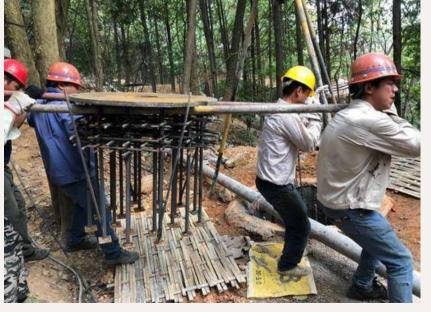
于公园半坡, 安装区域山体陡峭, 道路 弯曲,许多路段甚至无法行人,且植被 茂盛,还有许多名贵树种,难以开设运 输通道。为此,项目部结合轮式汽车 吊、索道、溜槽等方法将安装构件转运 至就近的卸料平台后, 再将安装好的桥 面人工搬运至施工作业点,同时依靠拔 杆、搭设钢管架等传统方式来进行安 装。施工难度大,且无法直接吊装大构 件,只能在现场焊接。为此,项目部安 排专人做好现场布置,清理施工场地内 的枯树、落叶, 作业时用水将周围浇湿 浇透,并配备灭火器、囤水水箱等应急 灭火工具,确保安全施工。
