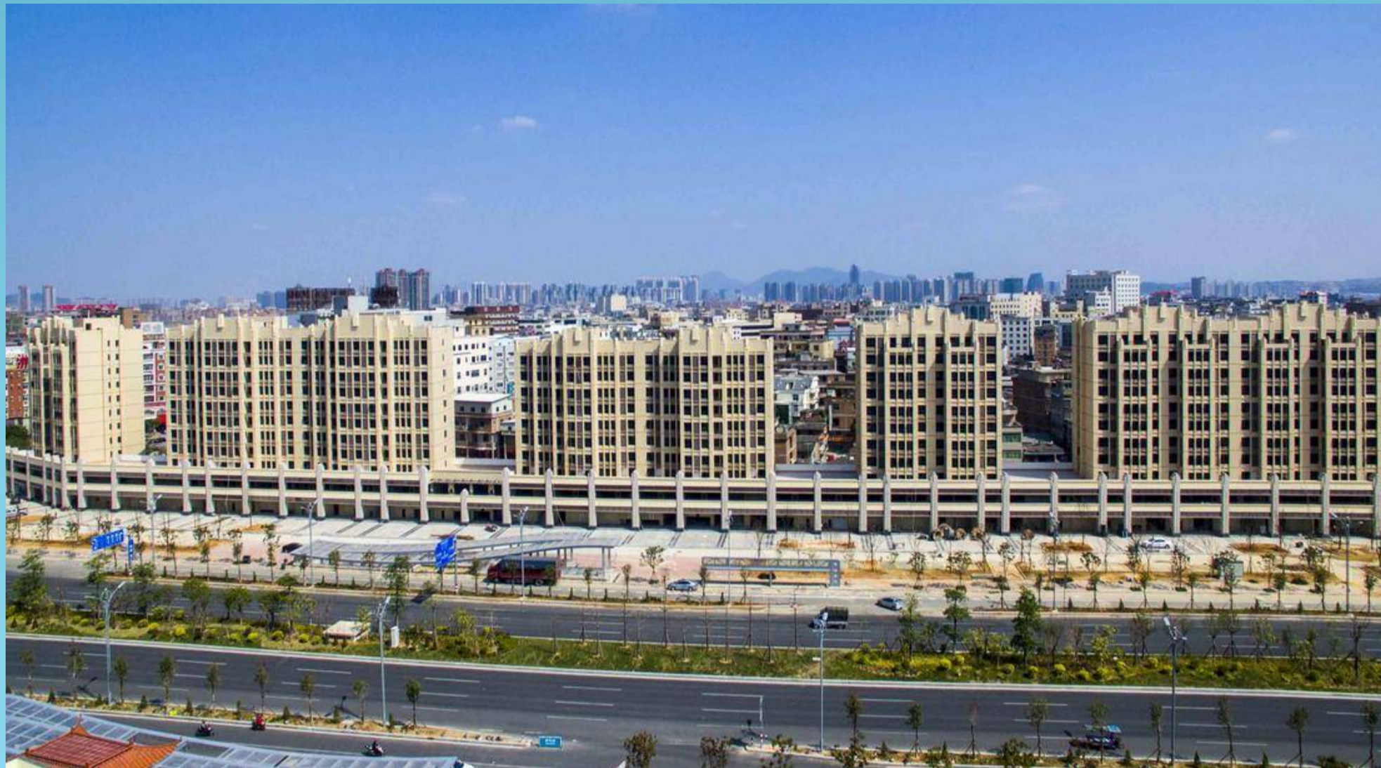
图为我司施工的晋江市鞋都片区改造项目安置房（市优质工程）
