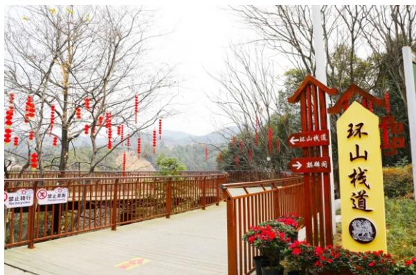
麒麟山栈道具有“适用、经济、绿色、美观”的特点。栈道通过与绿道连接线景观桥衔接，将麒麟山、儿童公园和绿道有机串联，设置的6个出入口，加强与景区内各景点的衔接，也方便医科学院、梅狮新村、博学家园等小区居民出入，保持在4%以内的坡度，满足无障碍通行，此为适用性；在确保安全的前提下，一方面通过适当调整栈道等高线高度，提高栈道稳定性，同时利用地灾点平台，减少桩基和柱墩造价等措施，压缩桩基部分
